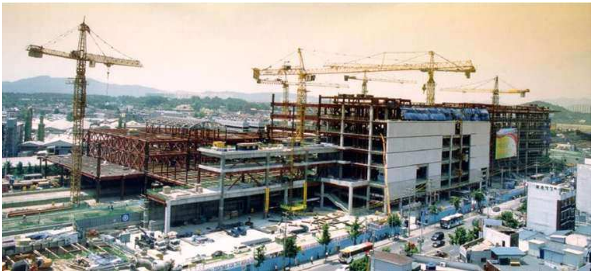
Mega Truss Travelling 공법(수원역 건축공사)
